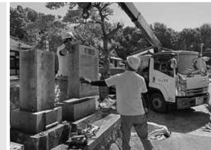
(株)美匠による墓石解体工事作業の様子
