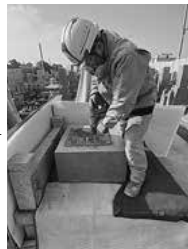
しっかりと養生した上で作業を進めています。
