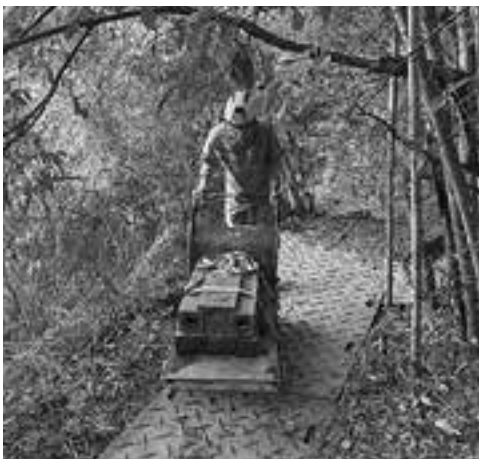
出来る限り石を小さく割り、しっかりと養生をした上で運搬することが大切です。
