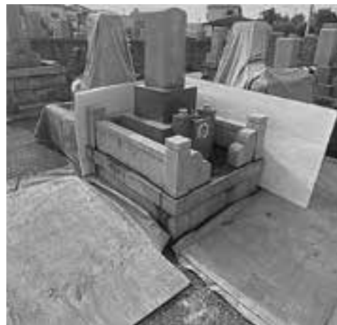
他のお墓の巻石や外柵に接触して傷を付けないよう、毛布やプラスチック板を使用して養生していきます。
